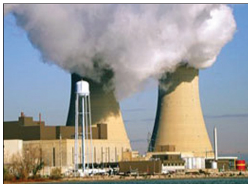
Mynd 2.14 Gufustreymi frá kjarnorkuveri. Myndin sýnir gufustreymi upp úr strompum kjarnorkuvers, þar sem geislavirk efni hafa verið notuð til þess að umbreyta vatni í gufu sem síðan knýr rafmagnstúrbínur áfram.
