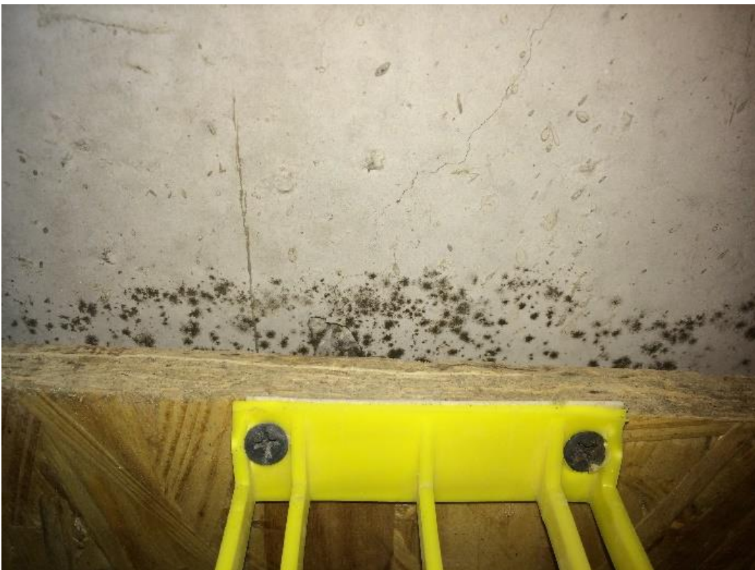
Mynd 3. OSB-krossviður er festur á kaldan steinvegginn og hann myglar og steypa einnig
