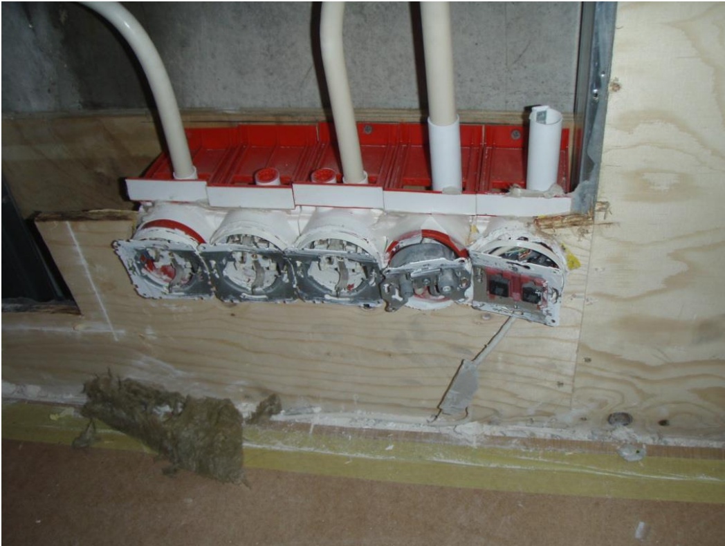
Mynd 2. Göt eru skorin í rakavörn til að koma fyrir rafmagnsdósum.
