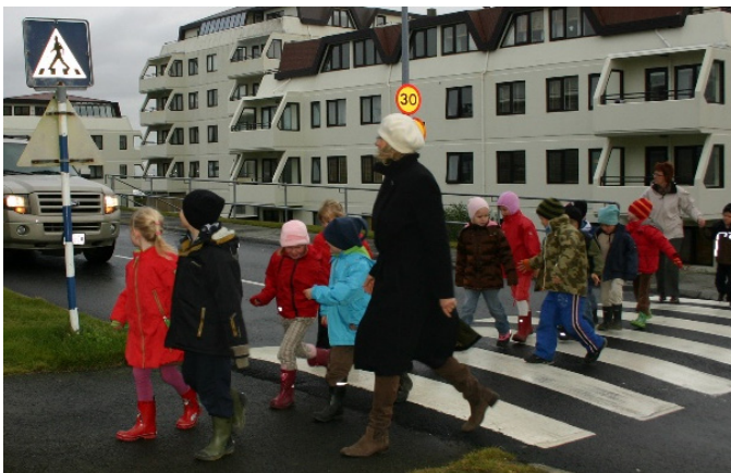
Mynd 13. Dæmi um yfirborðsmerkingu gangbrautar yfir akbraut
