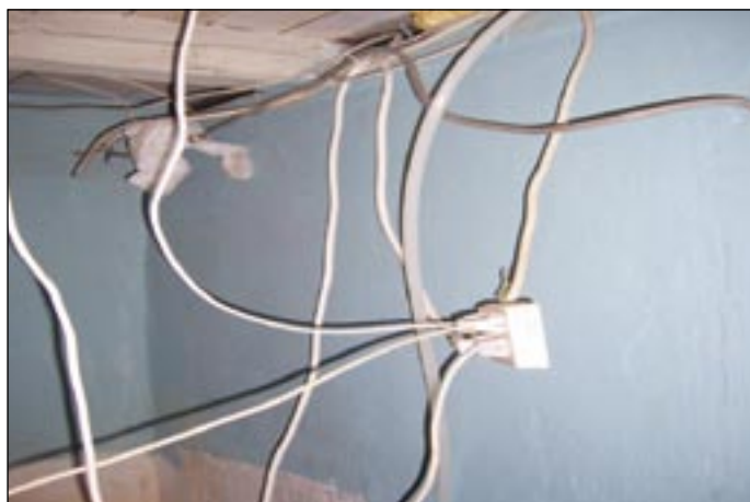
Mynd 6. Rangur frágangur raflagna og rafbúnaðar.
